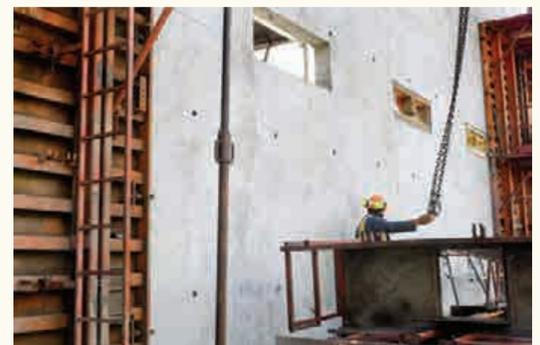
Coffrage pour la réalisation des voiles (murs) en béton.
