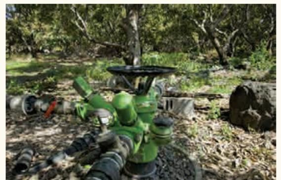
Une borne d'irrigation de l'Antenne 0. C'est sur cet équipement que les agriculteurs se branchent au réseau d'eau brute ILO.
