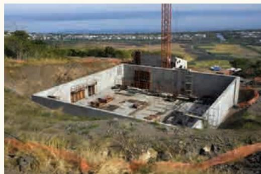
Un réservoir en construction le long de la chaîne de refoulement de l'eau de l'Antenne 2.
