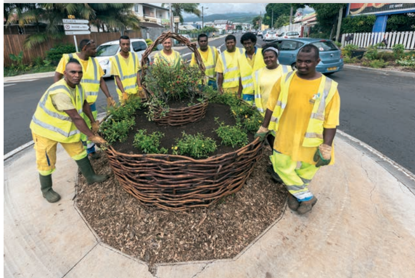
Chantier d'embellissement à Mille-Roches
