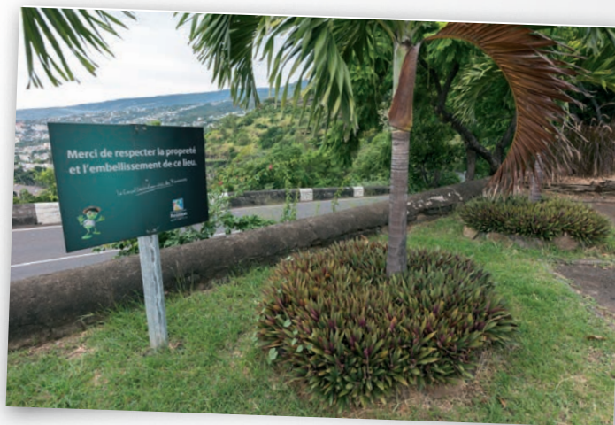
Chantier d'embellissement à la Montagne
