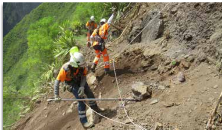
13/04/2021 Le sentier de la canalisation des orangers est rouvert.
