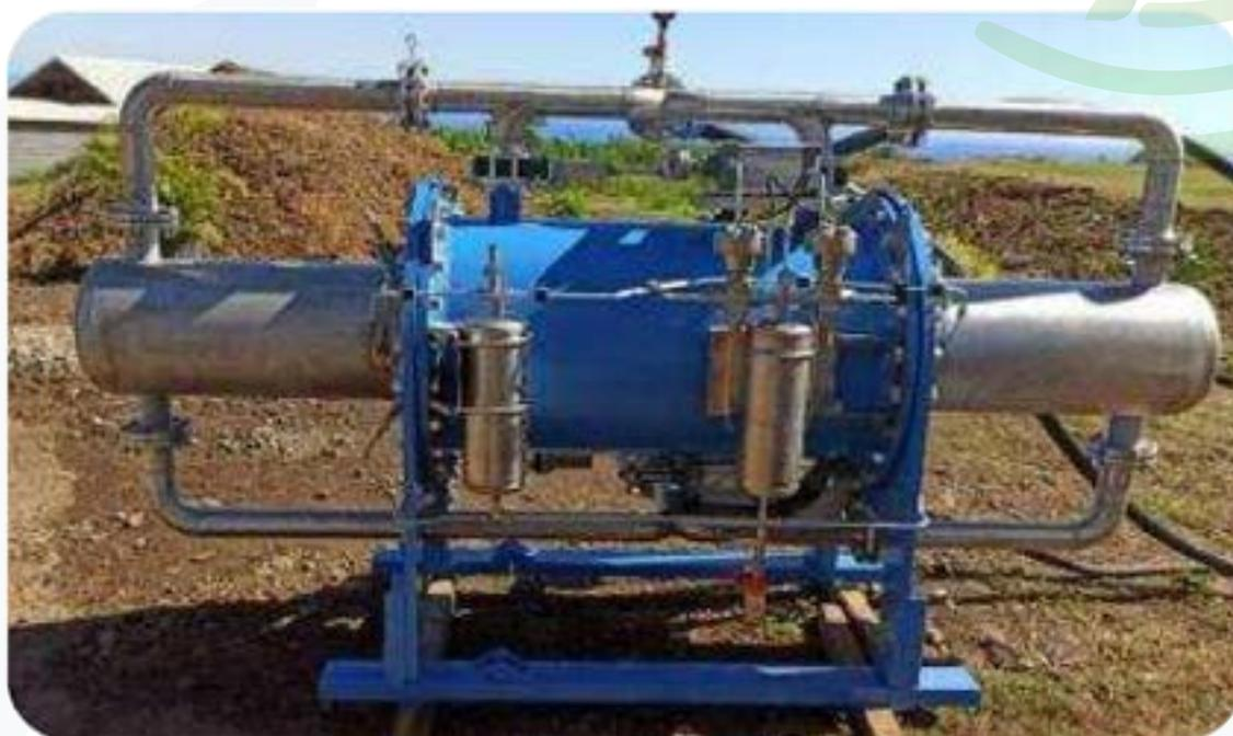
Dans un souci d'efficacité électrique, une pompe fonctionnant sans électricité conçu par la société UP WELLING (détention d'un brevet d'invention déposée à l'INPI) est actuellement en cours d'expérimentation sur l'infrastructure hydraulique départementale
