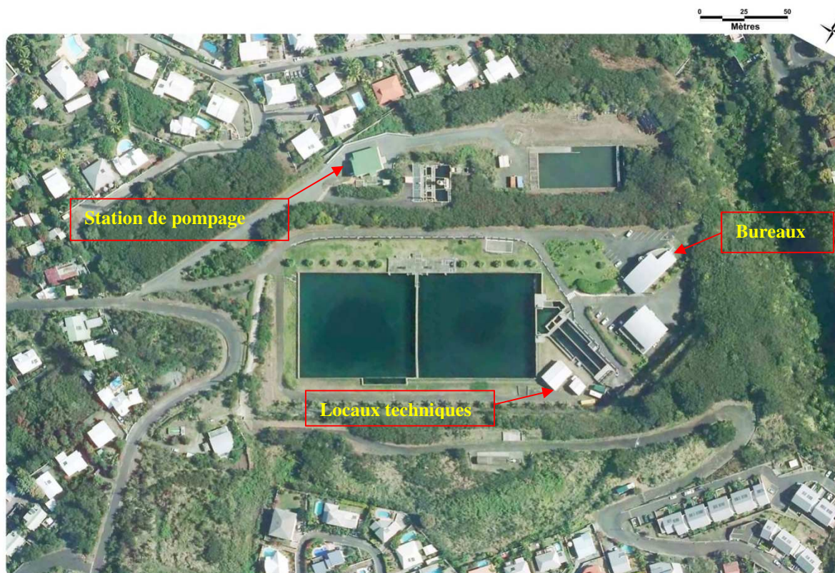
Figure 3 : Vue aérienne de présentation du centre technique de Mon Repos
