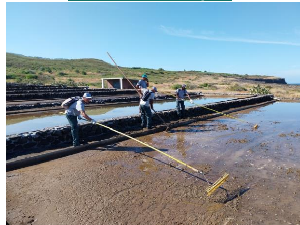
Entretien Bassin: enlèvement des algues
