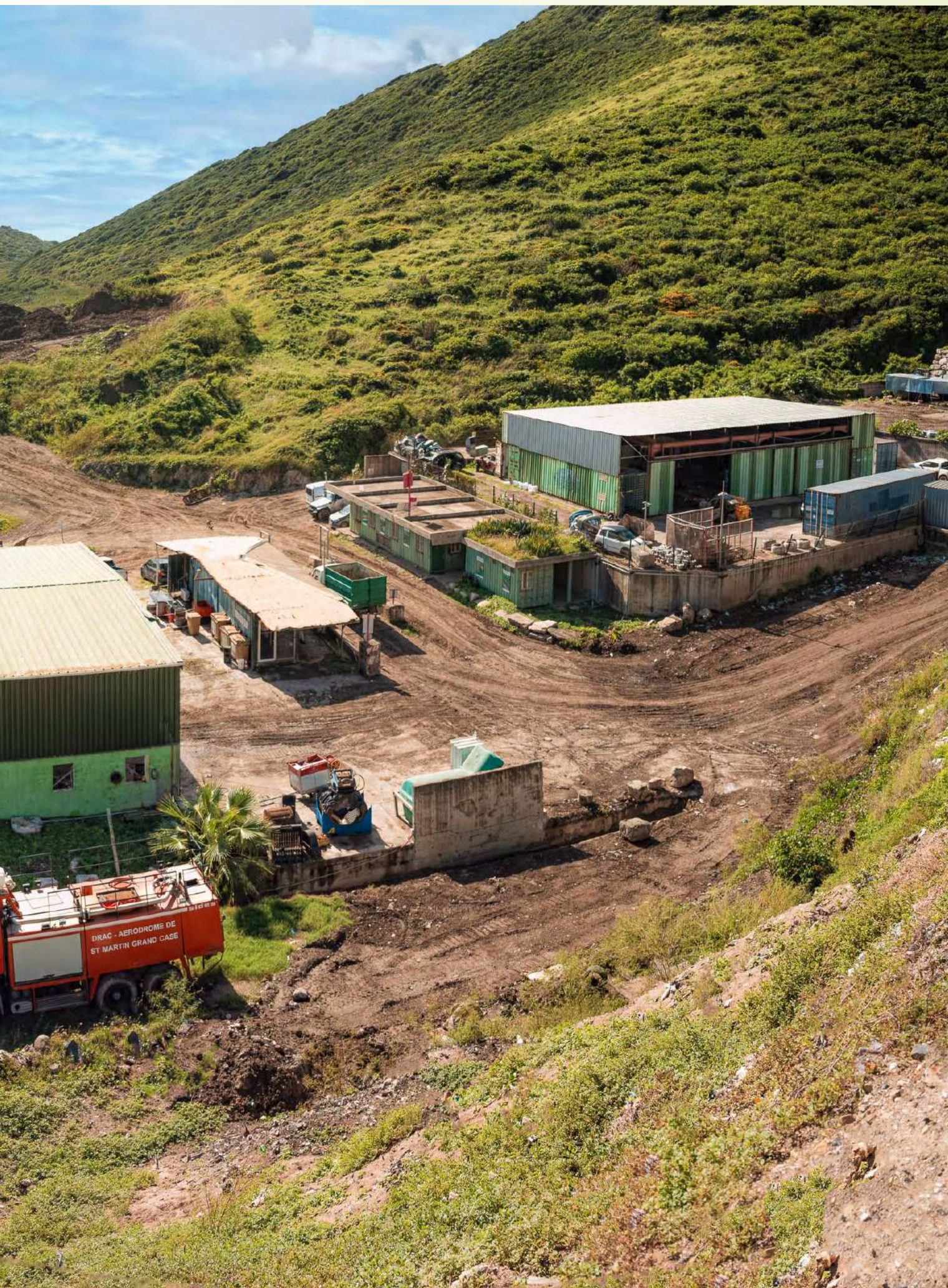
Ci-dessus : l'écosite de Grandes Cayes compte plusieurs ateliers, permettant par exemple de recycler les bouteilles en verre collectées en graviers et sables de verre, propres et non coupants, qui serviront notamment sur le site à la fabrication d'ouvrages en béton. © Verde SXM
